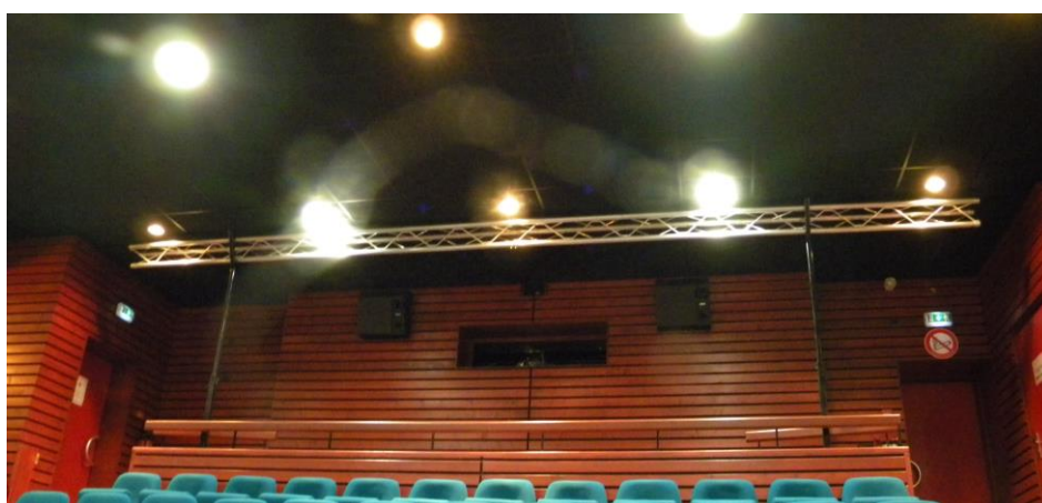
Structure de face (en fond de salle au sommet des gradins)
